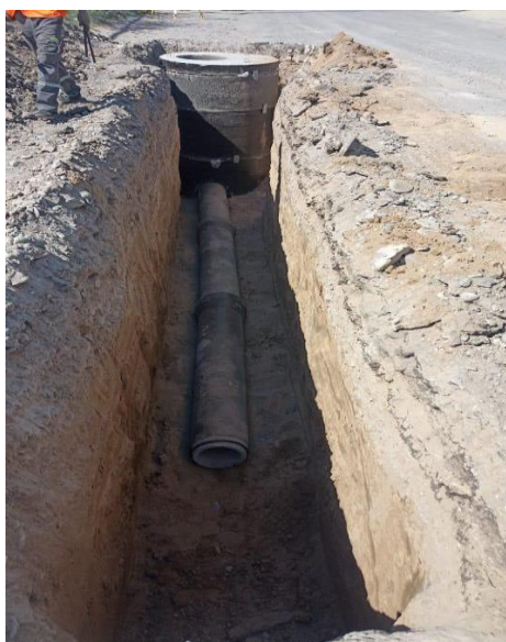
1.3-сурет – Ф300 қоңыраулы темірбетон құбырын салу процесі
