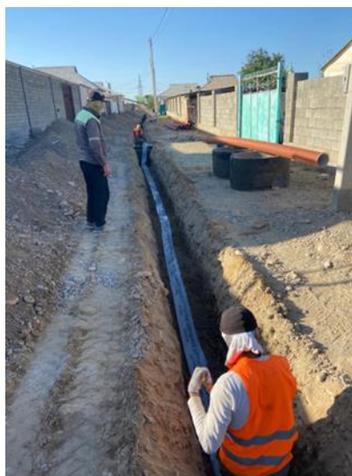
1.4-сурет - Кәріз сигналды лентасын 30см құм төсеуде салу барысы
